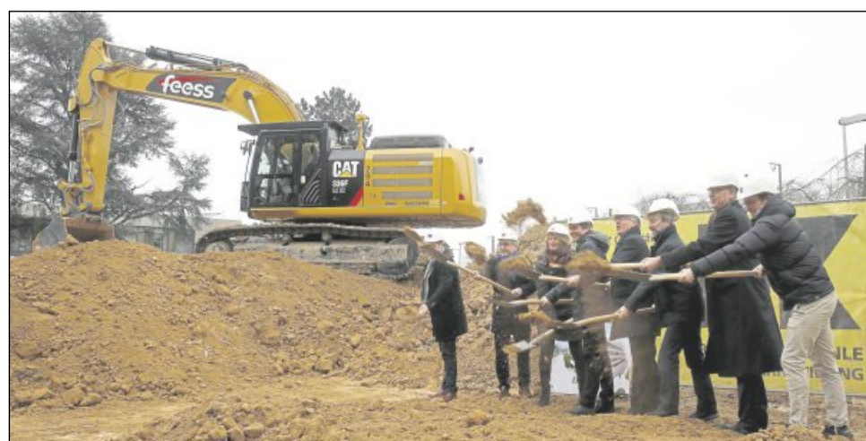
Vertreter des Kreisdiakonieverbands, der Stadt und des Bauunternehmens Kuhnle beim Spatenstich fürs neue Dienstleistungszentrum. Bild: Büttner
