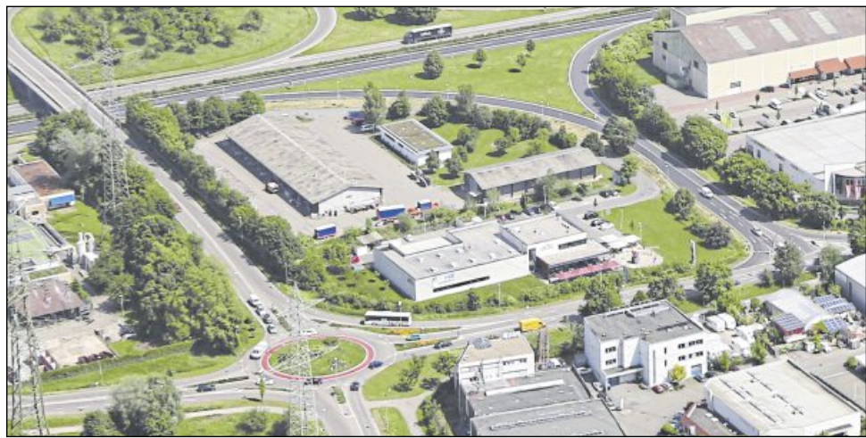
Auf dem Gelände der Straßenmeisterei an der B-29-Ausfahrt in Weinstadt-Beutelsbach ist genügend Platz. Ein Gutachten schlägt vor, den Straßenmeisterei-Stützpunkt Schorndorf zu schließen und den Betrieb nach Weinstadt zu verlagern.
