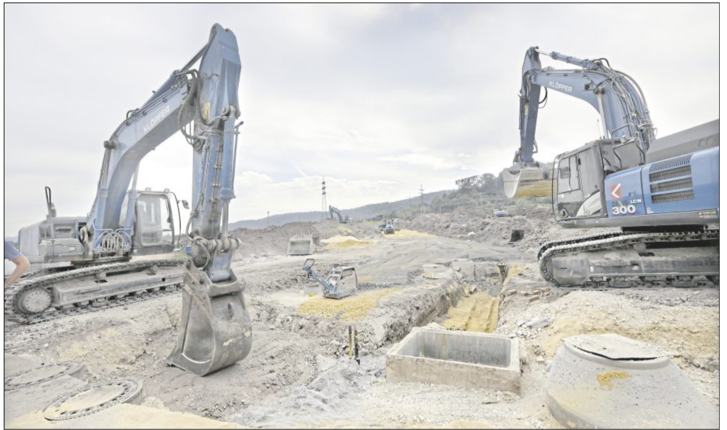
Aktuell werden hier noch Schächte gegraben, bald sollen hier Wohnräume erfüllt werden.
